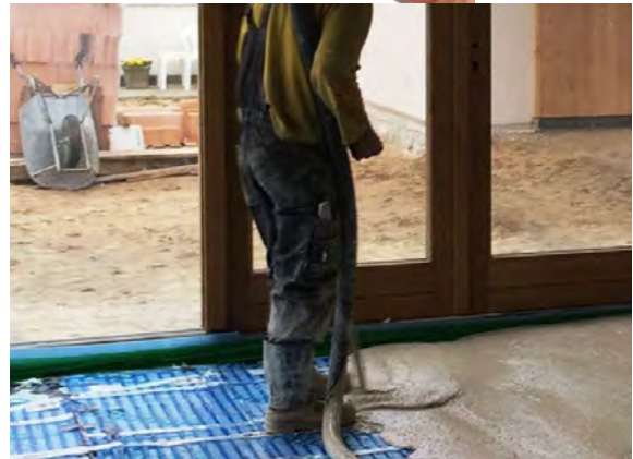
SOTTOPAVIMENTO A UMIDO IN CERAMICA/ MARMO
